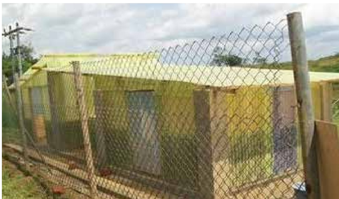
Photo 7.50. Séchoir solaire ELOUMAH, Mvuazi, 2014.
